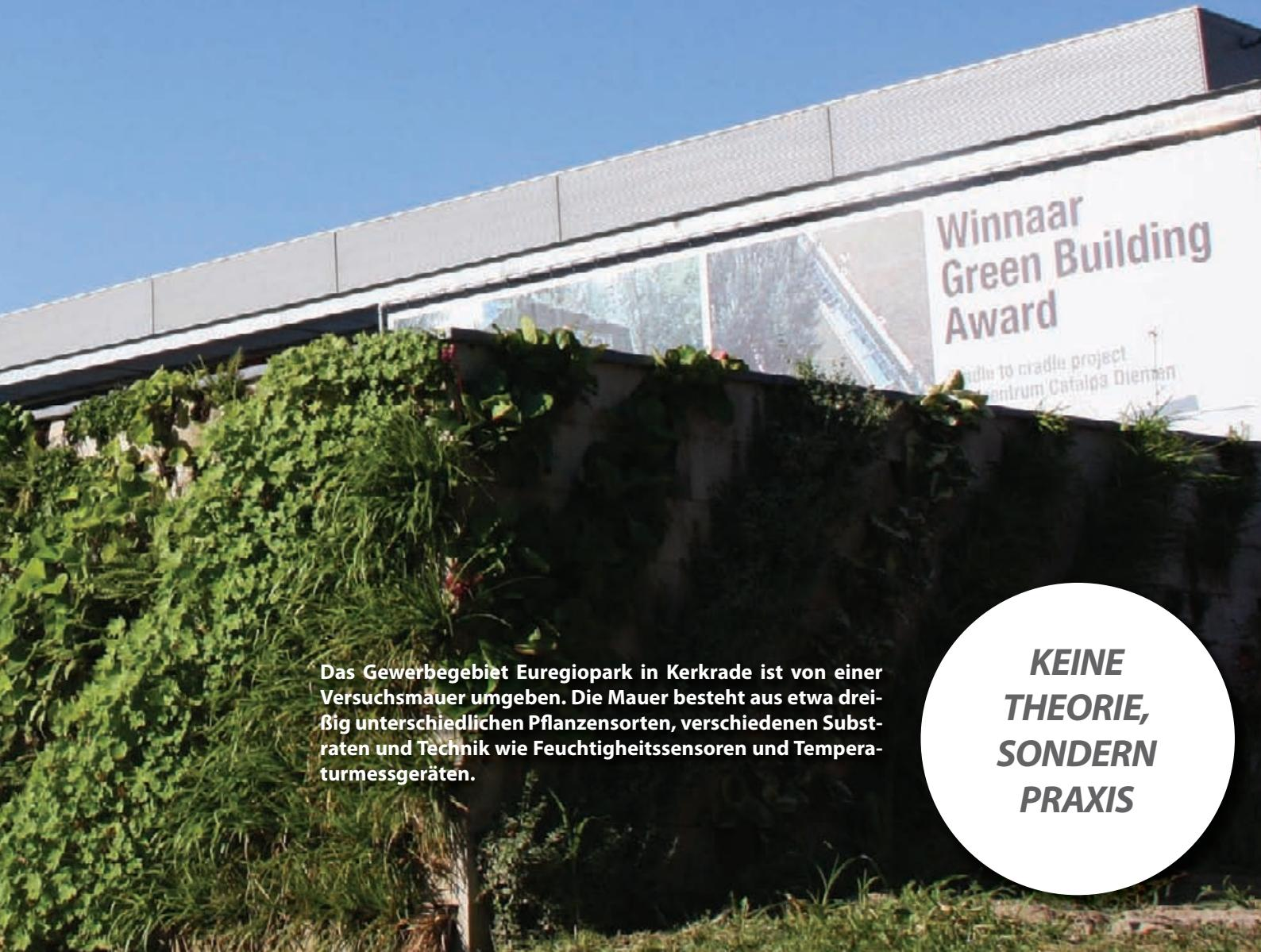
Das Gewerbegebiet Euregiopark in Kerkrade ist von einer Versuchsmauer umgeben. Die Mauer besteht aus etwa dreißig unterschiedlichen Pflanzensorten, verschiedenen Substraten und Technik wie Feuchtigkeitssensoren und Temperaturmessgeräten.
