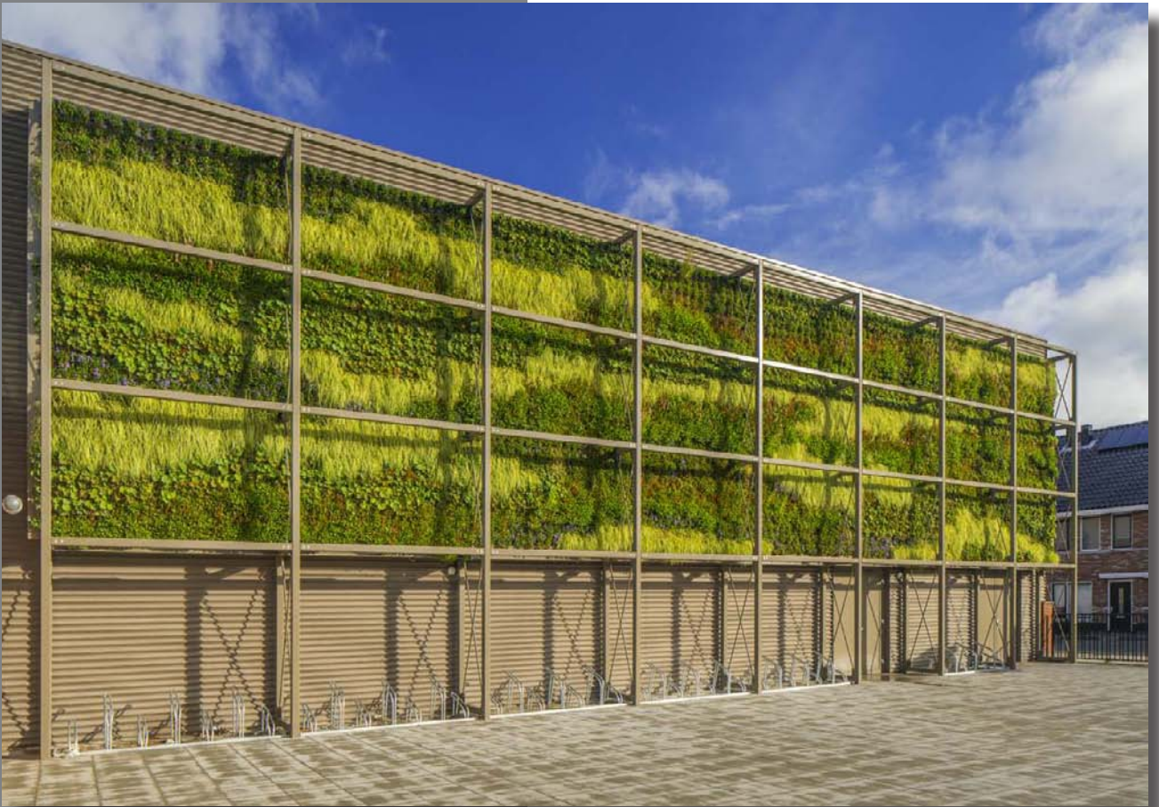
De F2 Facade enkele maanden na aanplant in de volle zomer
