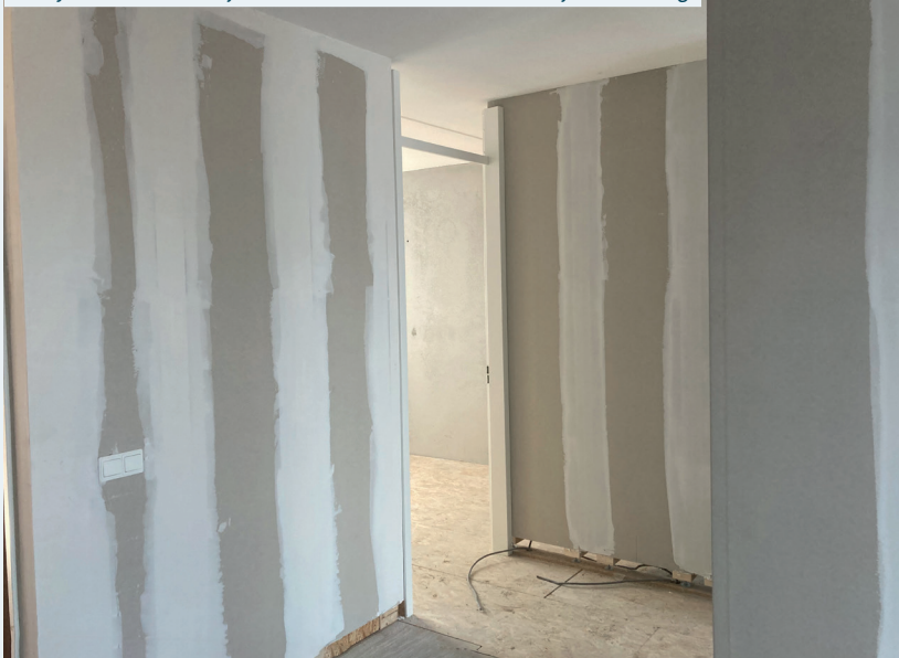
BIA Systeemwanden bij werkzaamheden van Novito in Wijk en Aalburg.
