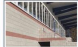
Lijmwerk - Schoonwerk - buiten
