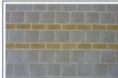
Metselwerk - Schoonwerk - buiten
