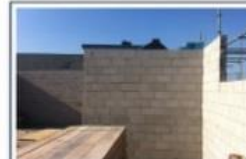
Metselwerk - Vuilwerk - binnen
