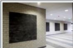
Metselwerk - Schoonwerk - binnen
