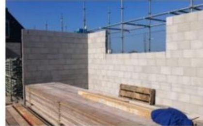
ECO Blok met 70% geëxpandeerde kleikorrels
