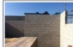
Metselwerk - Vuilwerk - binnen
