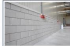
Lijmwerk - Schoonwerk - binnen
