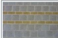
Metselwerk - Schoonwerk - buiten
