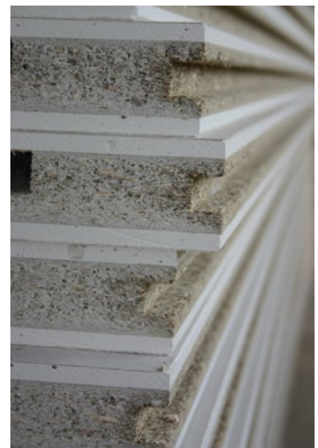
Faay VP54 panelen, met kern van vlasscheven en aan weerszijden gipskartonplaat.
